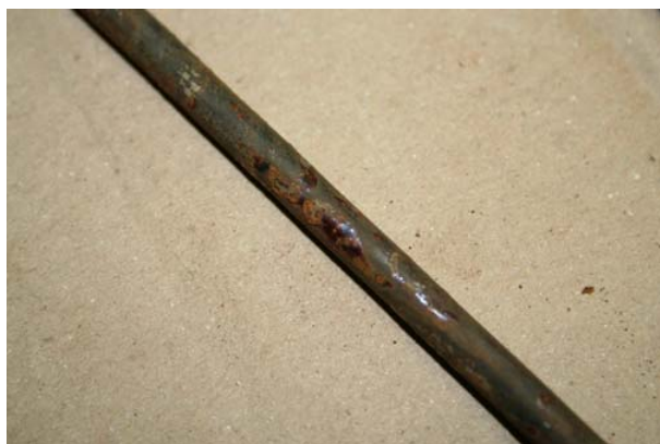
Punti di corrosione visibile successivamente alla spazzolatura.
